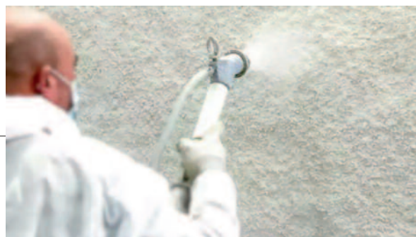
Aerogel wird auf ein Haus gespritzt
