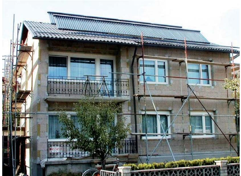
*Tektalan A2-E-21-Wärmedämmplatten auf Außenwand.*
