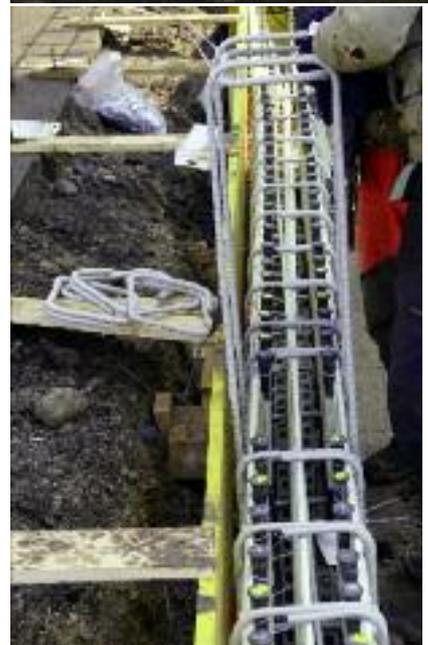
*ComBAR Stäbe mit Kopfbolzenverankerung nehmen in den Fundamenten die Querkräfte aus der Überbrückung des Bachlaufs auf.*
