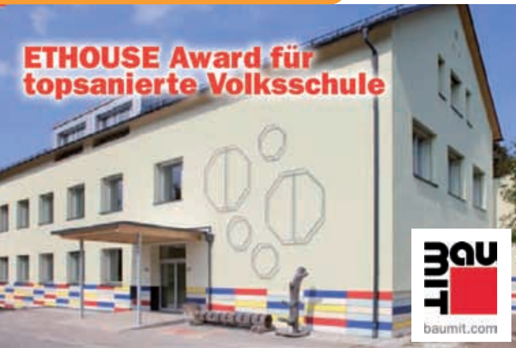
Dank durchdachter Sanierung darf die Volksschule Lind ob Velden seit Kurzem als Passivhaus gelten. Ein bunter Sockel verleiht dem energetisch vorbildlichen Gebäude nun auch eine kindgerechte Optik.
