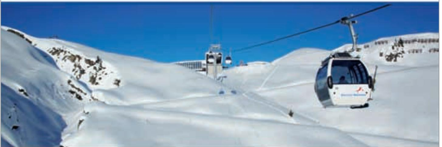
Die Doppelmayr Gruppe hat bei der Errichtung der Ber-Gondelbahn Grasjoch einen weiteren Meilenstein moderner Seilbahntechnik gesetzt: Sie ist weltweit die erste kuppelbare Gondelbahn, bei der durch ein innovatives Räumungskonzept sichergestellt wird, dass die Gondeln im Bergesfall garantiert in die Stationen zurückgebracht werden können.
