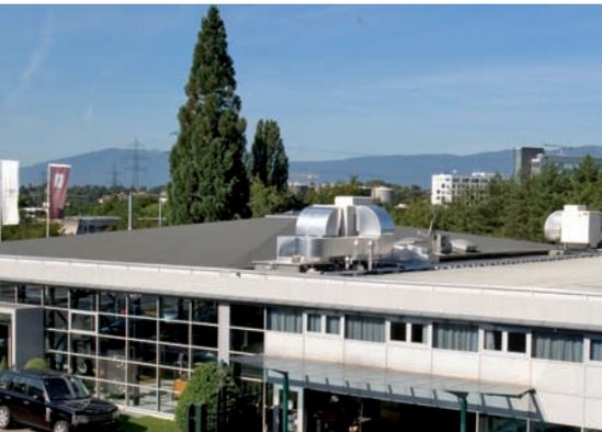
Bild 3: Dachinstallation von AdiaVent-Geräten
