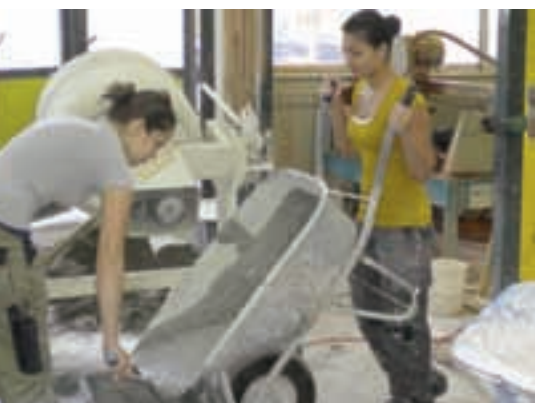
Schülerinnen in der Bau-Werkst./Bauhof bei der Arbeit!
