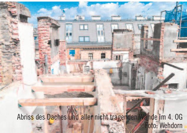
Abriss des Daches und aller nicht tragenden Wände im 4. OG
