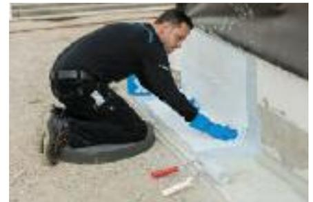
*Auch im Bereich der Bauwerksabdichtung spielen Flüssigabdichtungen ihre Vorteile aus: Triflex SmartTec eignet sich zur Anwendung bei Gebäudesockeln und Fundamenten, selbst wenn diese durchfeuchtet sind. Auch hier kommt das Spezialvlies zum Einsatz.*
