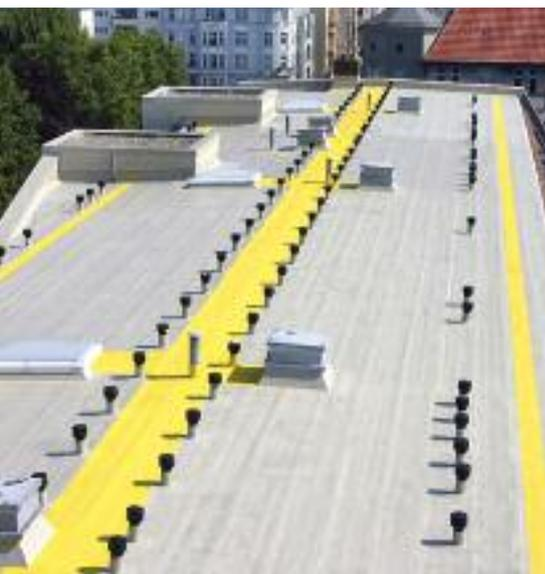
Diese Entwicklung kommt in Anbetracht der Materialeigenschaften nicht überraschend: Witterungseinflüsse und UV-Strahlung lassen Bitumen altern und spröde werden. Die Folge sind Brüche oder gar Löcher, insbesondere an den Schweißnähten. Die Funktionstüchtigkeit ist nicht länger gewährleistet. Nässe kann ungehindert in die Konstruktion eindringen und den Bestand gefährden.
