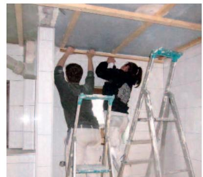
Bautechnikschüler bei der Montage der Gipskartondecke
